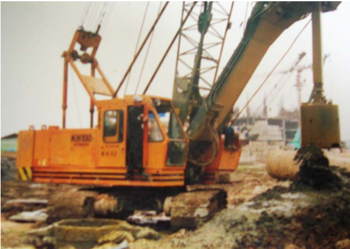
Máy khoan cọc nhồi thùng đào
